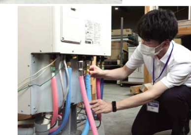
エコキュート設置研修風景(豊田SC内)
