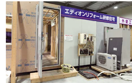
リフォーム研修センター (豊田SC内)
