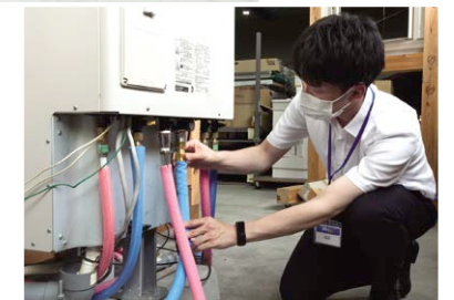
エコキュート設置研修風景(豊田SC内)
